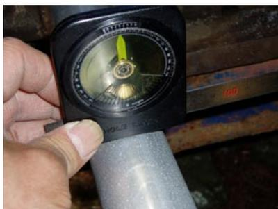
エレメントはパイプを貫通するので穴を明ける位置の基準になる鉛直を確認する。
