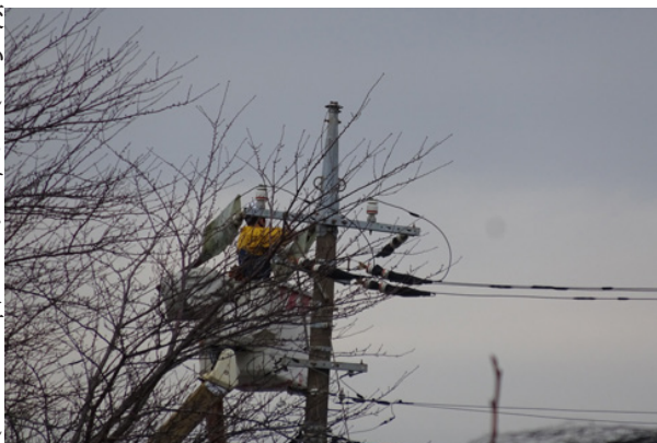
作業状況北側 6600V の電線
