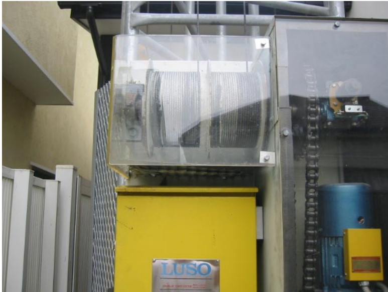
写真4 修理後のドラム周辺
