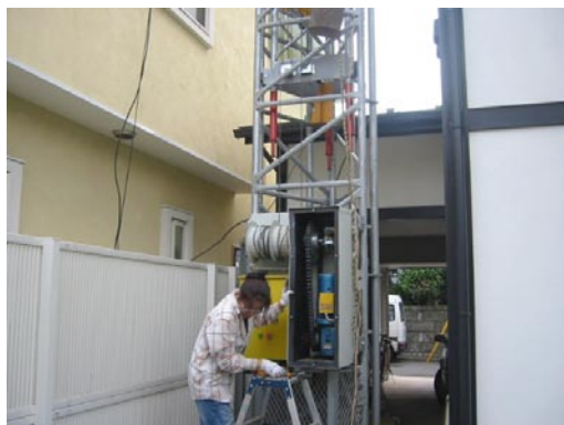
写真3 絡まったワイヤーの取り外し中
