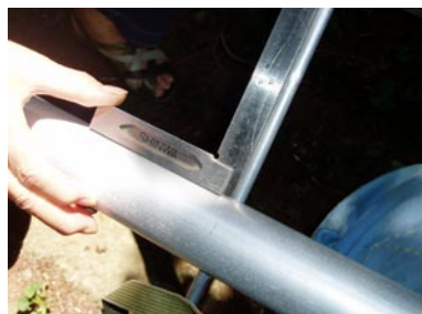
穴をあけ終わったらパイプを通し直角を確認する。
