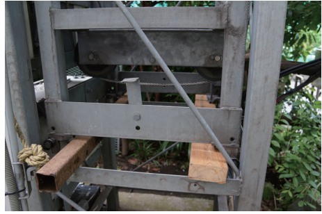
下のストッパーの少し上に角材を差し込み タワーの落下を防ぎます。
