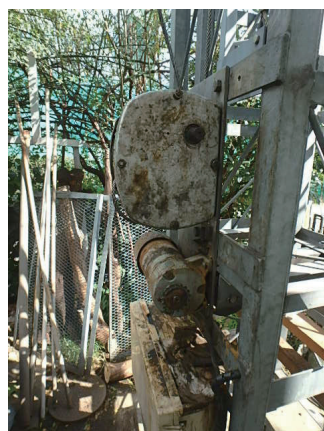
Eリングを外しメインギヤを取外します。 ギヤボックスのねじを緩めると中から水が吹き出てきました。
