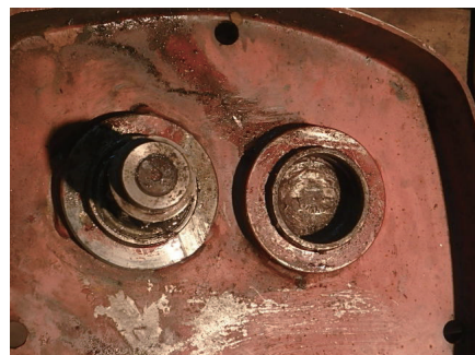
ギヤボックスの蓋側、右側のベアリングの内部がなくなっておりギヤの軸が外れてこすれた痕がありました。
